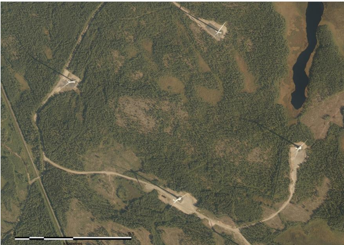
Kuva 4-1. Esimerkkikuva toiminnassa olevasta tuulivoimapuistosta. Tuulivoimaloita varten on rakennettu huoltotiet ja nostokentät. Tuulivoimaloiden ympäristössä ja välialueilla aikaisempi maankäyttö on säilynyt ennallaan.
