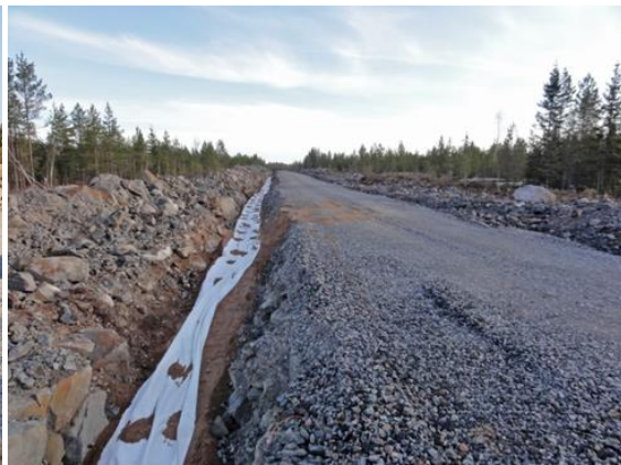
Kuvapari 4-12. Maakaapelit upotetaan pääsääntöisesti huoltoteiden yhteyteen (Kuvat: FCG).
