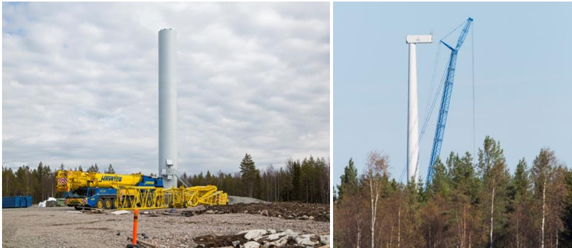
Kuvapari 4-14. Tuulivoimalan kokoamista (Kuvat: FCG).
