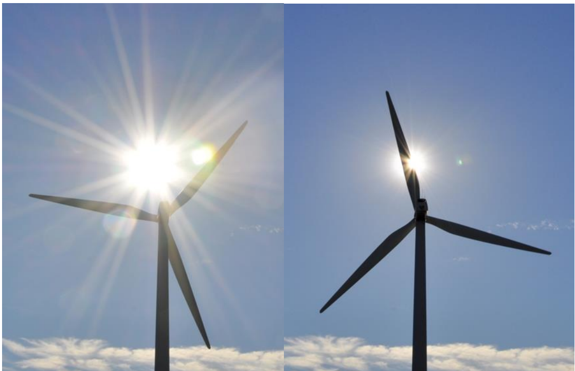
Kuva 17-9. Tuulivoimaloiden lavat aiheuttavat pyöriessään vilkkumista ja varjon välkkymistä aurinkoisella säällä.
