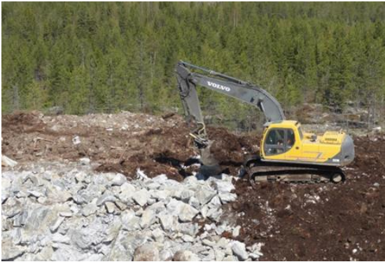
Kuvapari 4-11. Tuulivoimapuiston rakentaminen alkaa huoltoteiden ja pystytysalueiden rakentamisella (Kuvat: FCG).
