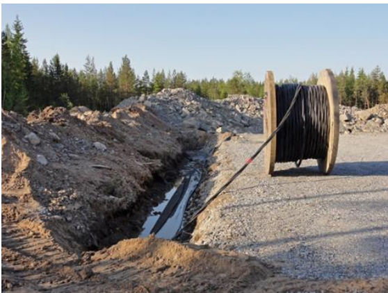
Kuvapari 4-12. Maakaapelit upotetaan pääsääntöisesti huoltoteiden yhteyteen (Kuvat: FCG).
