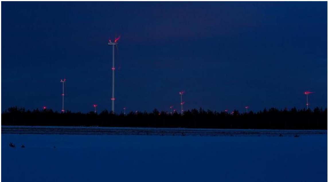
Kuva 4-4. Kiinteät punaiset lentoestevalot. (Kuva: FCG)
