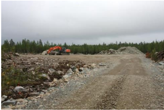
Kuvapari 4-11. Tuulivoimapuiston rakentaminen alkaa huoltoteiden ja pystytysalueiden rakentamisella (Kuvat: FCG).
