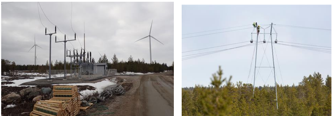
Kuvapari 4-15. Sähköaseman ja voimajohdon rakentamista. (Kuvat: FCG)
