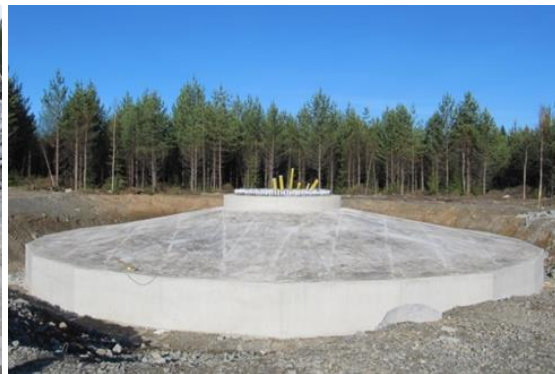
Kuvapari 4-13. Tuulivoimalan perustusten rakentamista (Kuvat: Leila Väyrynen, FCG).
