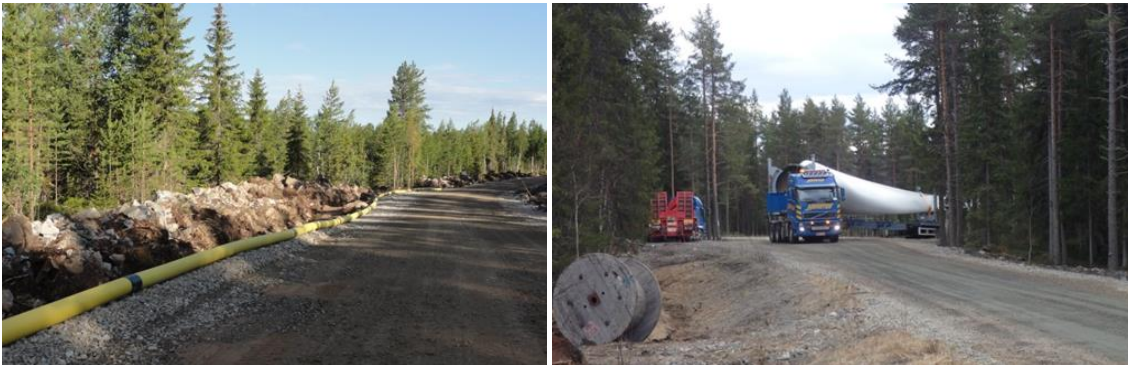
Kuvapari 4-7. Vasemmalla: Esimerkki tuulivoimapuiston rakennus- ja huoltotiestä. Maakaapeli sijoitetaan ojakaivantoon tien reuna-alueelle. Oikealla: Tuulivoimalan osia kuljetetaan erikoiskuljetuksina. (Kuvat: FCG).
